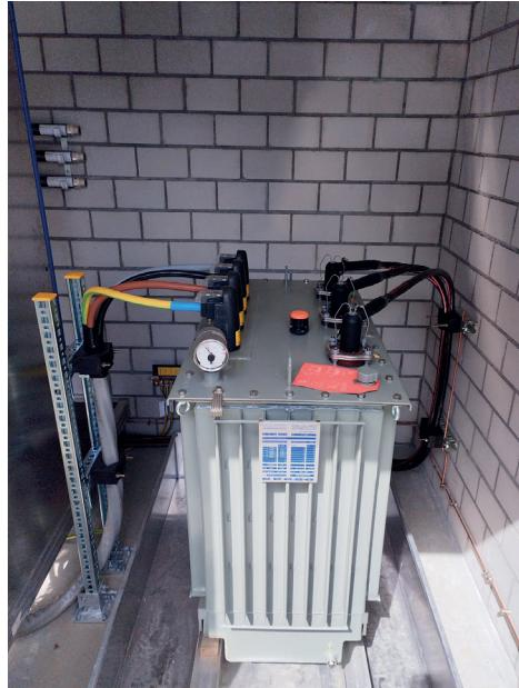
*Trasformatur dalla Repower che transforma la tensiun da 16kV sin 400V*
